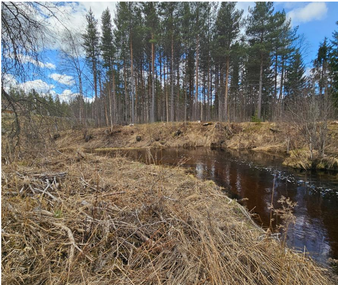
Figur 4-3 Bilde av Kiva nedstrøms for eksisterende jernbanebru, i sørgående retning. Bildet viser omtrent posisjon for kryssing med ny bru. Bilde tatt 30.04.2025.
