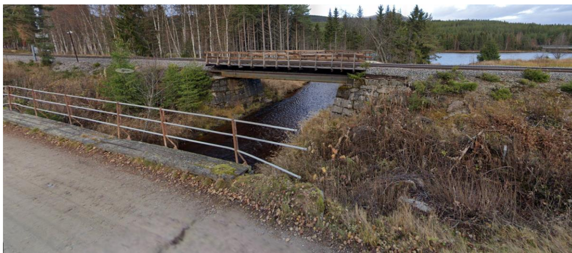
Figur 4-2 Bilde fra Stasjonsvegen i retning jernbanebrua over Kiva. Brusted blir nedstrøms for jernbanebrua. Glomma synlig i bakgrunnen. Bilde fra oktober 2019 via Google Maps.
