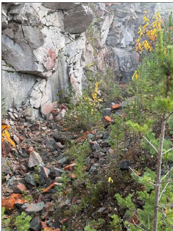
Figur 22: Forsenkning ved bruddkanten i dagens uttak på kote 423. Det er ikke antydning til vann her i dag (Foto: HB/Feste NØ as)
