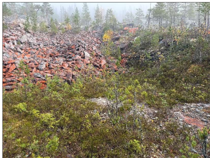
Figur 23: Foto fra fremre kant av dagens brudd på kote 420. Det er ikke antydning til vann/fuktutslag her (Foto: HB/Feste NØ as)
