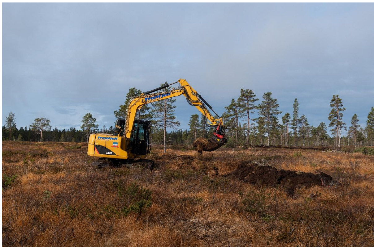
Figur 44 viser Tronfjell Maskin sitt arbeid på Vollmyra under restaurering i 2024. Her hos grunneier Christian E. Kiær.
