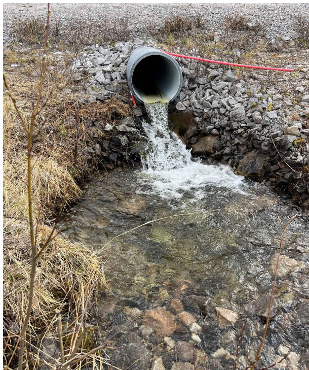
Figur 3-7. Bekk 2 oppstrøms jernbane. Venstre: vandringshinder gjennom kulvert under RV3. Høyre: variert og godt substrat, men lite kantvegetasjon. Foto: Sunniva Buvarp, 30.04.2025.
