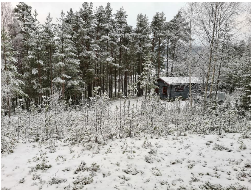
Fig.4 Bildet viser eksisterende renseanlegg. Bildet tatt fra nord mot sørvest. Omkransende vegetasjon gjør at anlegget ikke har negative fjernvirkninger.
