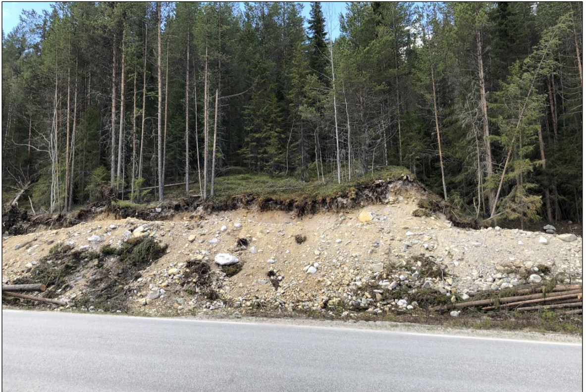
Figur 9: Løsmasseskråning på oversiden av Hanestadvegen ved Tømmerdalen.
